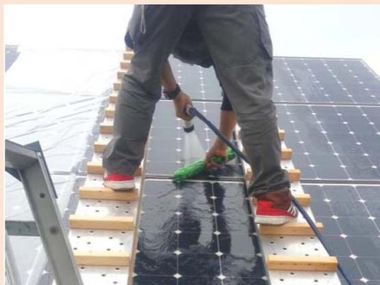
ホームセンター等で販売されている足場板（出来ればアルミ製が軽くて良い）2m程度のものに、5cm厚程度の角棒を切断しボルトで取り付けます。
