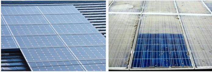
ソーラーパネルの汚れ対策（発電効率低下の防止）に
